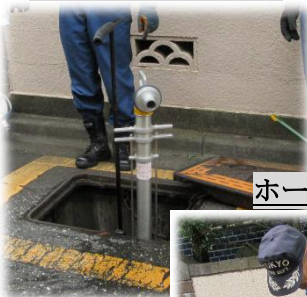
消火栓への装着完了
