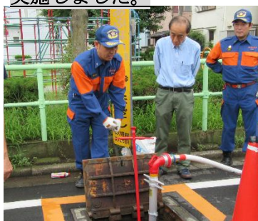
スタンドパイプを消火栓から外す作業状況
