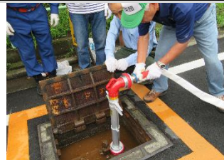
スタンドパイプにホースを装着作業
