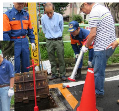
スタンドパイプを消火栓から外す作業状況
