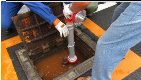
スタンドパイプを消火栓に装着作業
