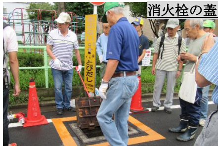
スタンドパイプを消火栓に装着作業
