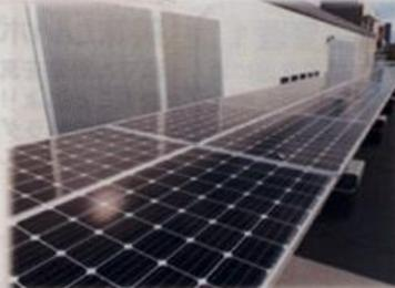
屋上に太陽光パネルを設置し、発電した電力を施設内で有効活用しています。災害などの停電時には、施設内直結のコンセントから、発電した電力の使用が可能となります。
