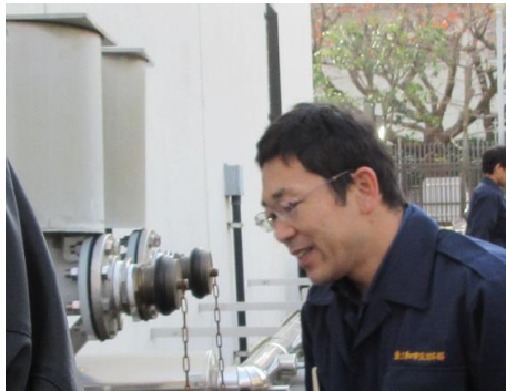
開栓後蛇口を開放して放水する (錆等不純物を流し出す)
