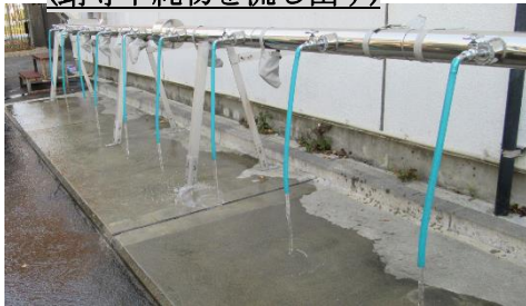
開栓後蛇口を開放して放水する (錆等不純物を流し出す)
