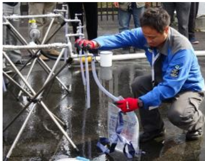
簡易給水装置の解体状況
