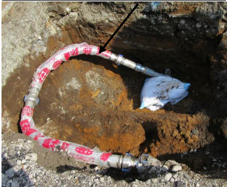
業務用管での仮本管への接続状況
