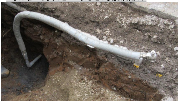
仮本管から個人宅への引き込み接続作業終了
