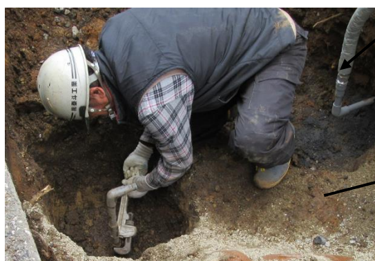
仮本管から個人宅への引き込み接続作業終了
