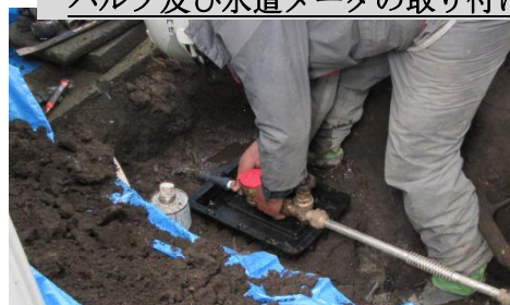
バルブ及び水道メータの取り付け作業
