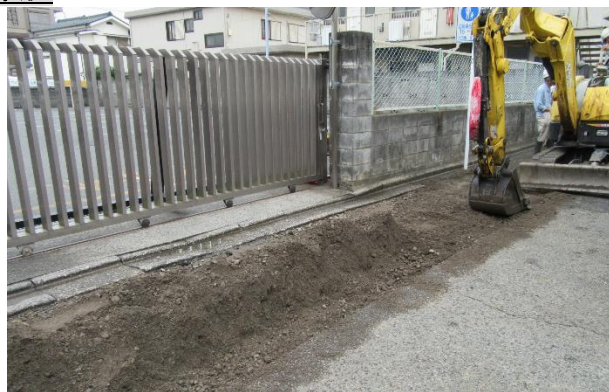
仮舗装の下地整地作業完了状況
