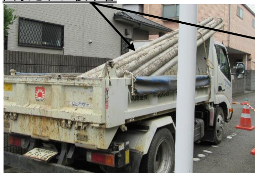
回収された仮本管
