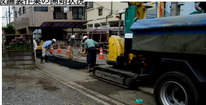
仮舗装作業の開始状況
