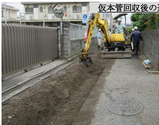
仮舗装の下地整地作業完了状況
