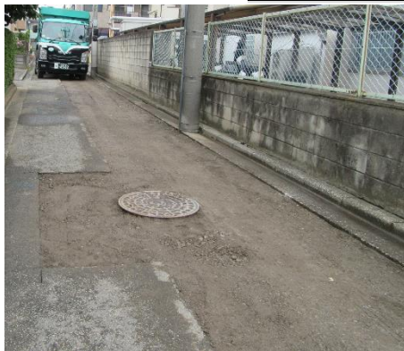
仮舗装の下地整地作業完了状況
