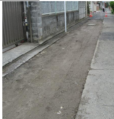
仮舗装の下地整地作業完了状況
