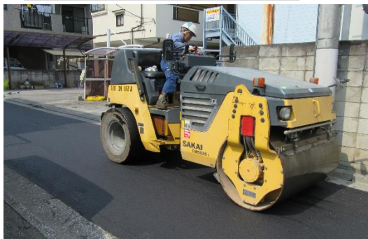
本舗装のローラー圧縮作業状況
