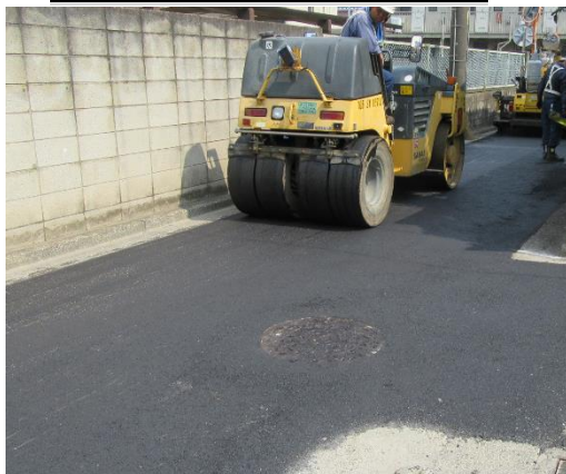
本舗装のローラー圧縮作業状況
