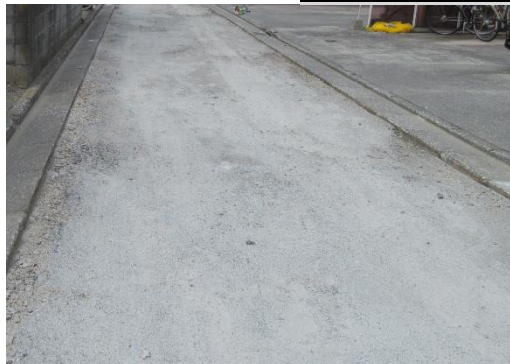
本舗装の下地整地作業完了状況
