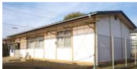
東大和市立南街公民館 南街・桜が丘地域防災協議会 平成24年03月31日
