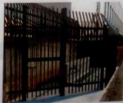
▲ 区画された応急給水エリア
