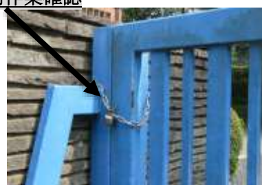
閉門作業確認
