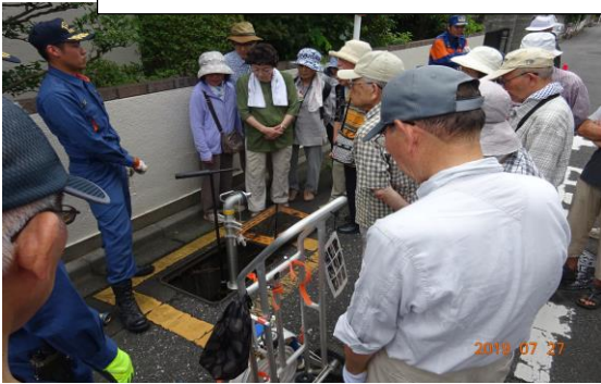
さび抜きをし、スタンドパイプをセット。
