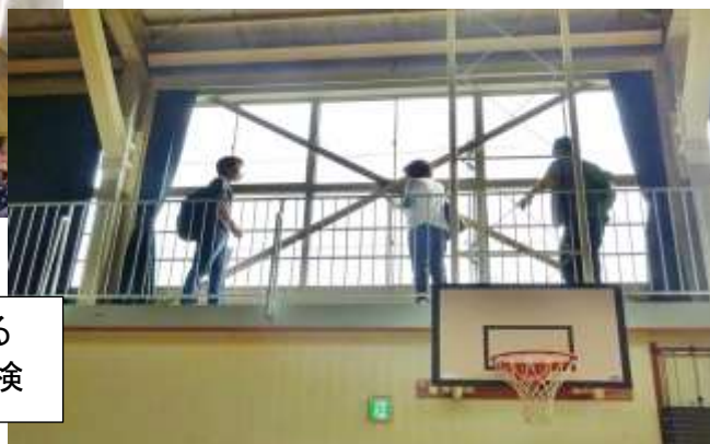
復旧班による 新校舎の点検
