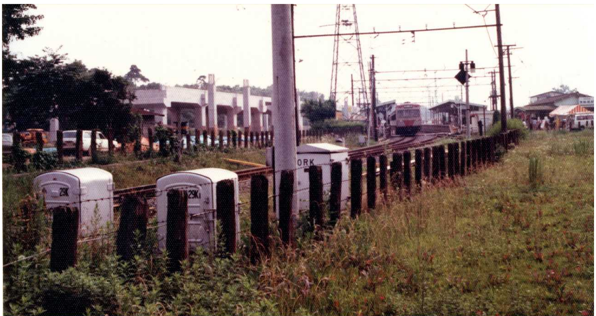
昭和50年代初め高架工事が進む青梅橋駅
