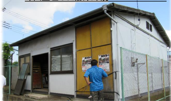
今回整理した倉庫外観
