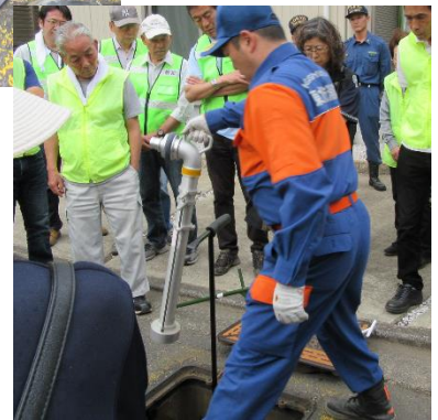
スタンドパイプを 消火栓に接続
