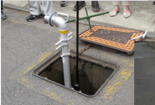
スタンドパイプを接続した状況
