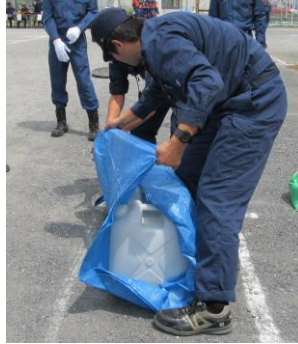
ポリタンクを利用した簡易土嚢の作り方
