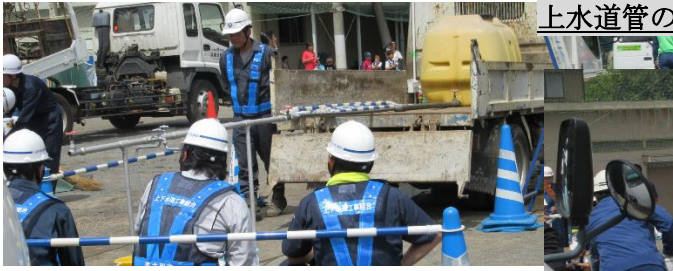
建設車両による作業状況
