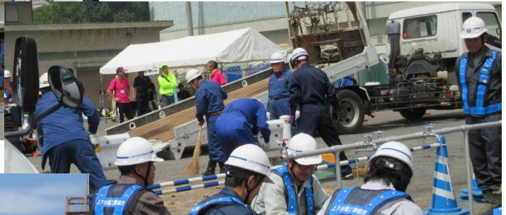
上水道管の修理状況
