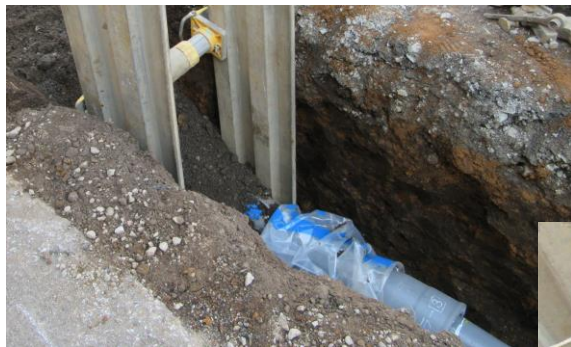
本管埋設工事状況(下水管との交差を屈曲管で対応)
