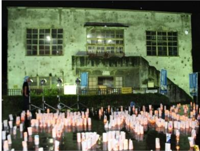
ライトアップされた旧日立航空機株式会社変電所と点灯された平和祈念キャンドル
