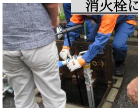
消火栓にスタンドパイプセットを接続
