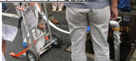
消火栓にスタンドパイプセットを接続
