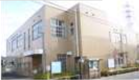
東大和市立南街公民館
