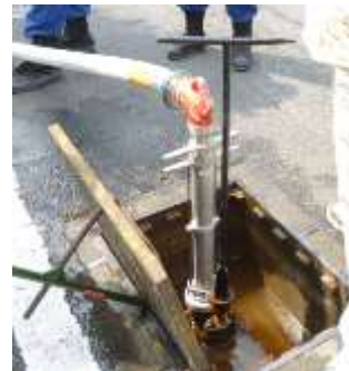
消火栓への装着完了
