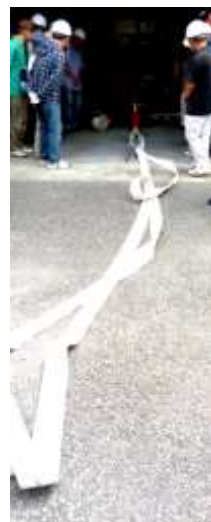
展張されたホース
