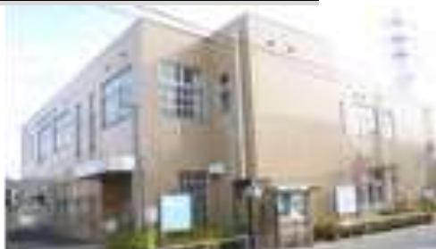
東大和市立南街公民館
