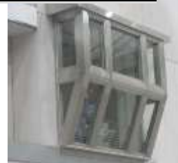
クレーン操作室
