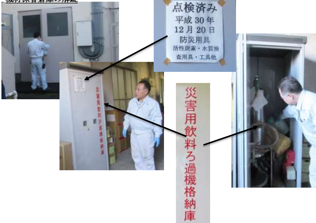
機材保管倉庫の解錠
