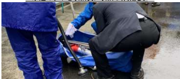
水道キットを収納袋に収納し作業完了
