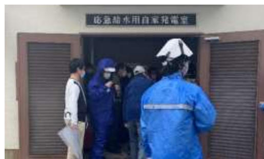
発電機室へ入り発電機の稼働手順説明
