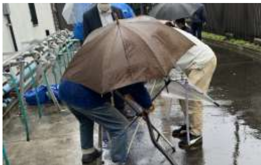
水道キット解体作業
