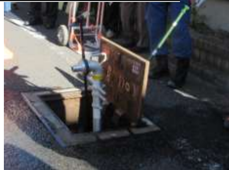
簡易水道キットを脱着した状態
