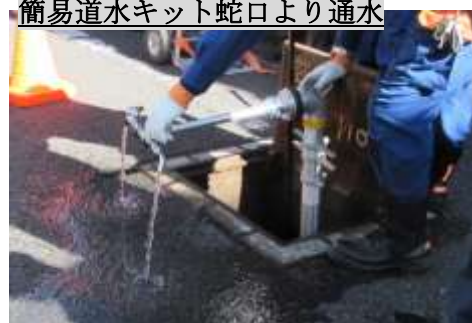
簡易水道キット蛇口より通水
