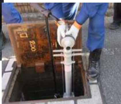
スタンドパイプの消火栓へのセッティング
