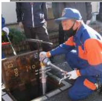
簡易水道キットのスタンドパイプセットへの装着説明
