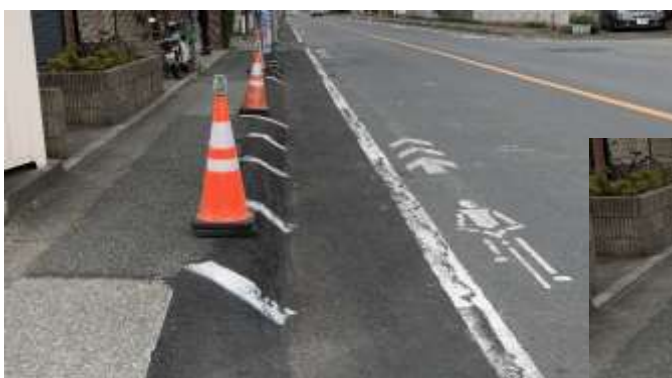
中央通り側から北への工事区間の撮影
