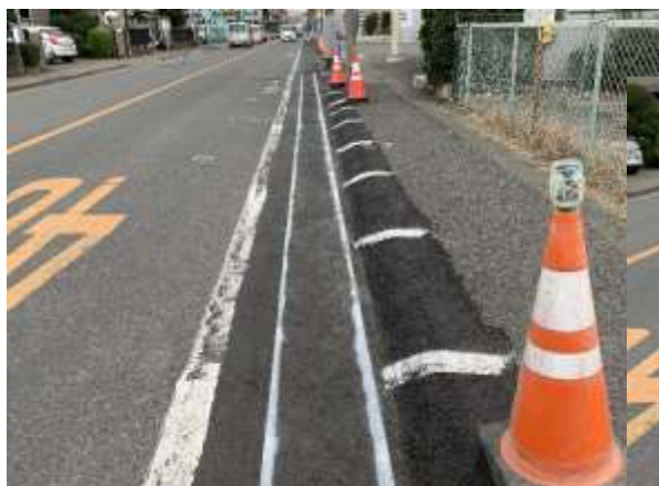
りそな銀行側から南への工事区間の撮影
