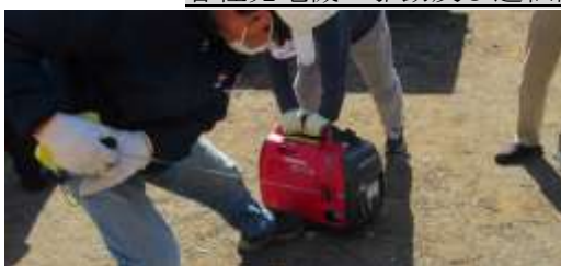
各種発電機の駆動及び運転確認
