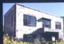
旧日立航空機株式会社変電所
