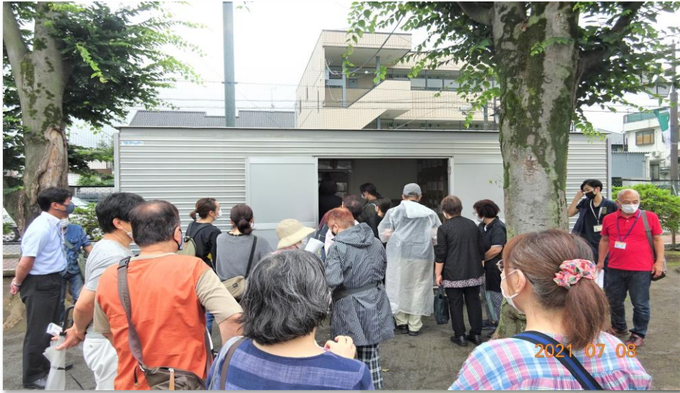
倉庫内の点検
