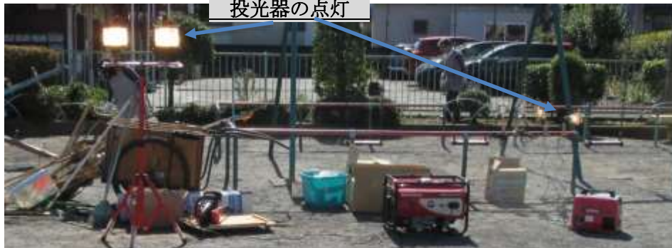
投光器の点灯
