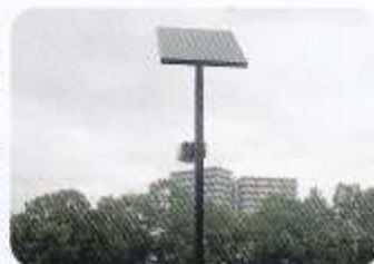
防災用照明灯 (ソーラー照明灯)
