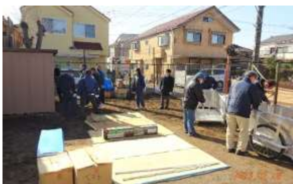
防災倉庫より、 各資器材の搬出。
