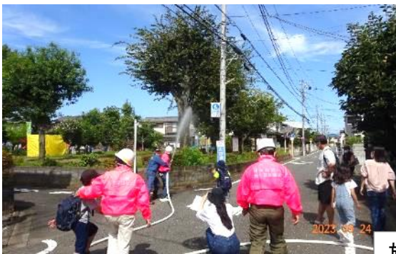
スピンドルドライバーで徐々に水を流し、さび抜き。
