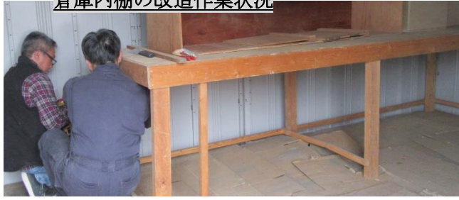
整備後の倉庫内状況(大倉庫)
