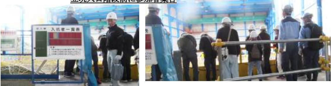
立坑昇降階段
