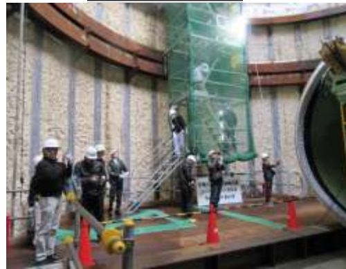
立坑底部へ到着
