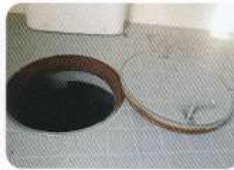
防災トイレ (常設) 地下に便槽を持ち、災害時に洪水や漏水などのインフラが寸断された場合でも利用できるトイレです。災害時には、蓋を開けて使用します。
