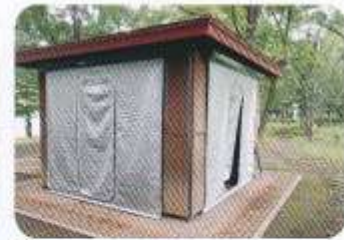
防災あずまや 災害時には、側面の幕を下ろし、避難スペース等として使用します。
