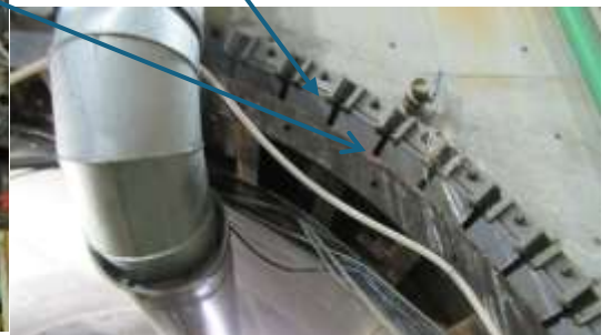
入り口には鋼製セグメントを使用
