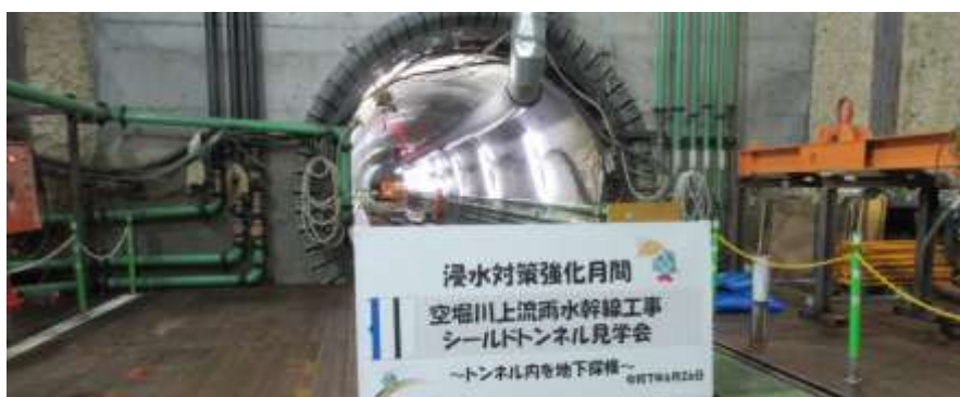
シールドトンネル入り口
