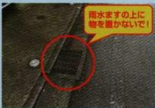
●道路の側道に設置される「雨水ます」が下水道への雨水の入り口になります。
