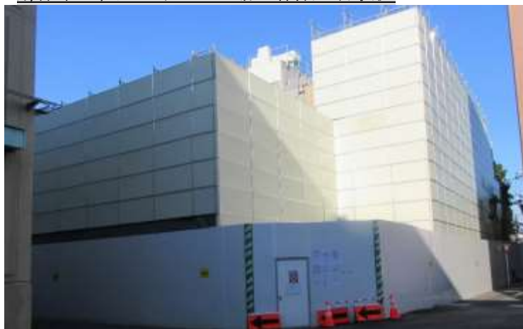
解体中の粗大ごみ処理工場の作業進行状況
