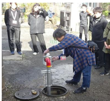
検査容器に、検査の為の水道水を取る。
