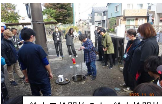
給水元栓開放の上、給水栓開放
