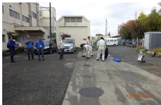
マンホールトイレ外蓋の開放
