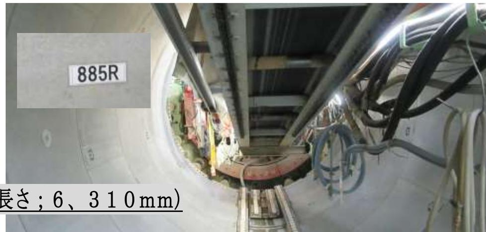
シールドマシンの外観(外径 ; 3、840mm,長さ ; 6、310mm)
