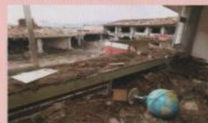
東日本大震災石巻市の様子
