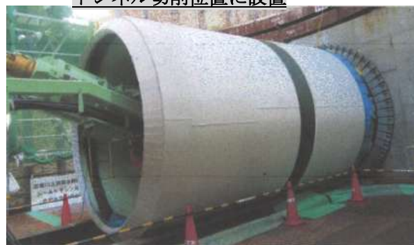
図3；シールドマシン設置状況 トンネル切削位置に設置
