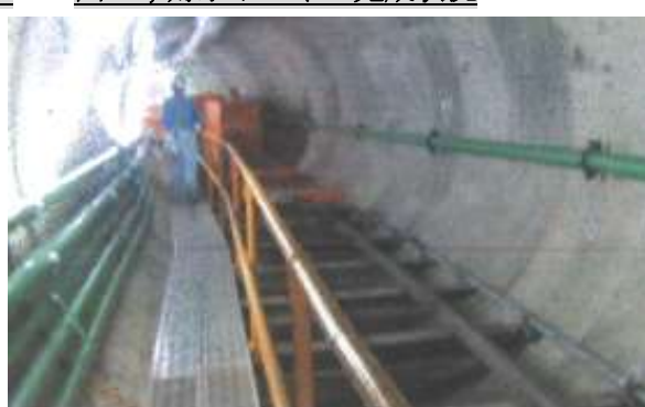
図8 ; 貯水トンネル完成状況
