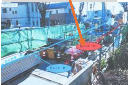
図18；けやき通り(立坑)取水孔
