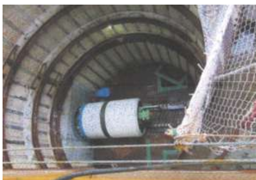
図4；上中原公園立坑完成図／シールドマシン設置状況
