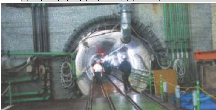
図7 ; 上中原公園立坑から貯水トンネルスタート地点
