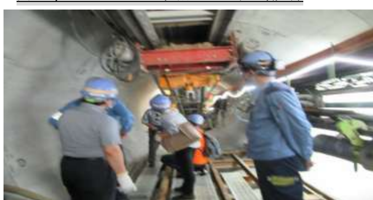
図10 ; シールドマシン切削のトンネル最先部
