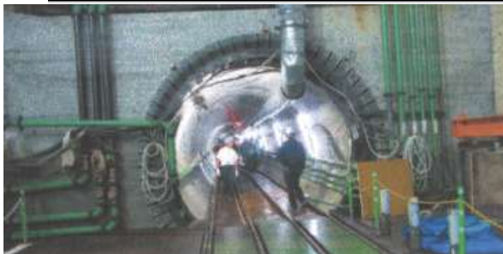
図7 ; 上中原公園立坑から貯水トンネルスタート地点
