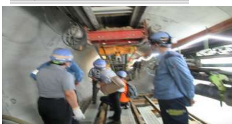
図10 ; シールドマシン切削のトンネル最先部
