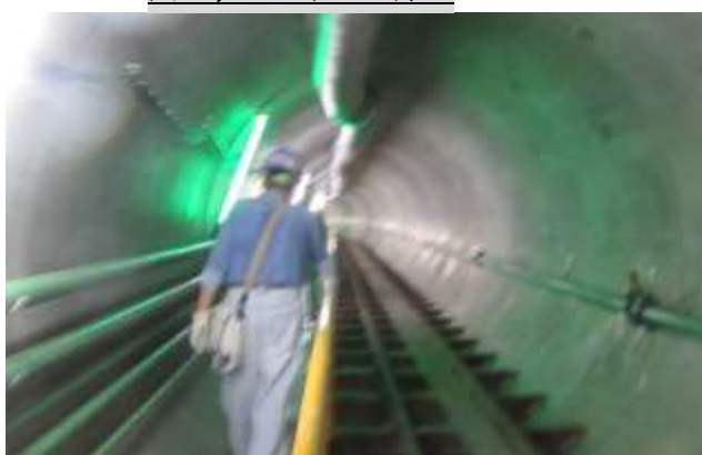
図9 ; トンネル内部
