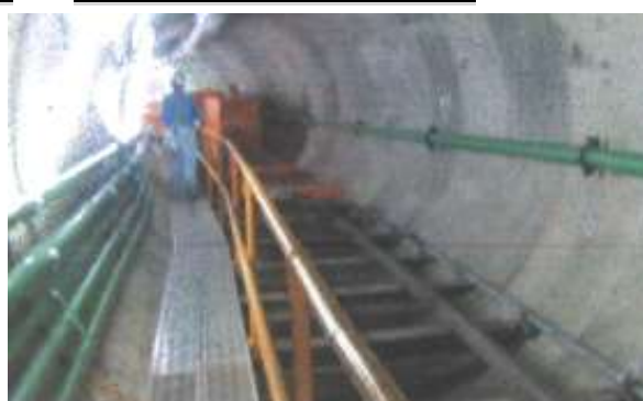
図8 ; 貯水トンネル完成状況
