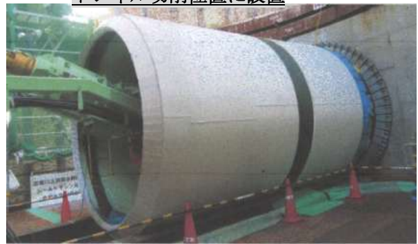
図3；シールドマシン設置状況
